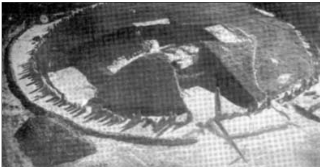
Fig. 10.- Deterioro del monumento de Mezora. Fotografía de Ponsich en los años sesenta.
