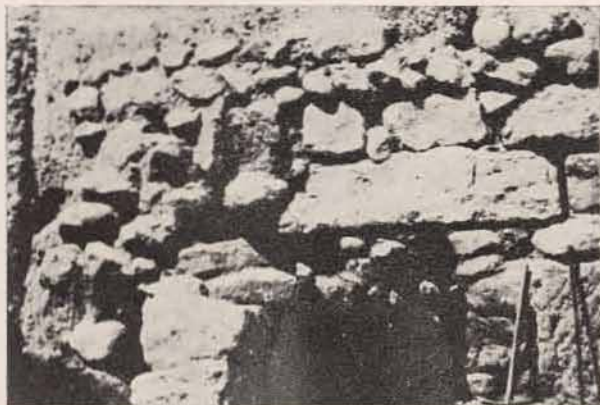
1.—Monforte del Cid.—Vista interior del architrabe y muro
