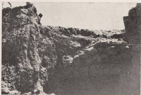
1.—Monforte del Cid.—Detalle de la capa de tierra que cubría la construcción antes de la campaña de excavaciones de 1941
