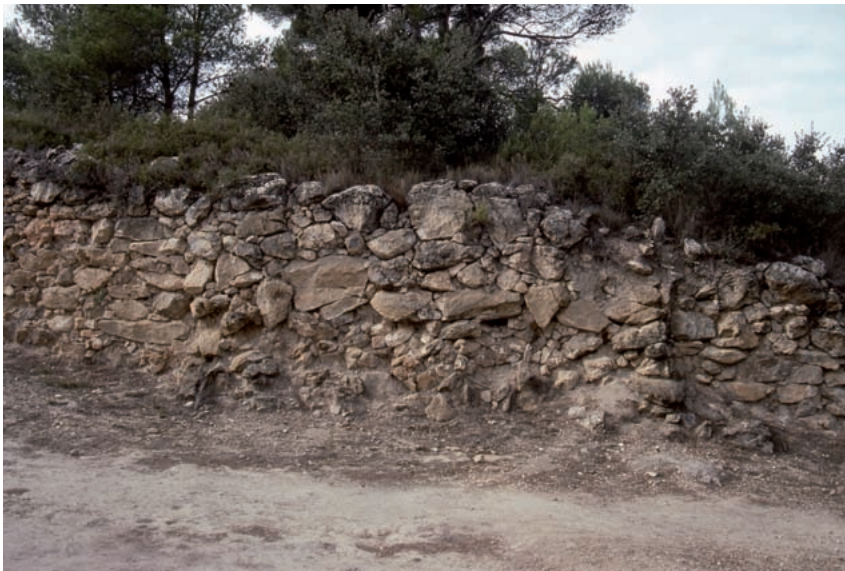
3. Lienzo de la muralla oeste antes de la consolidación.
