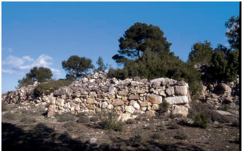
14. Lienzo oeste de muralla y torre antes de la restauración. 1994.
