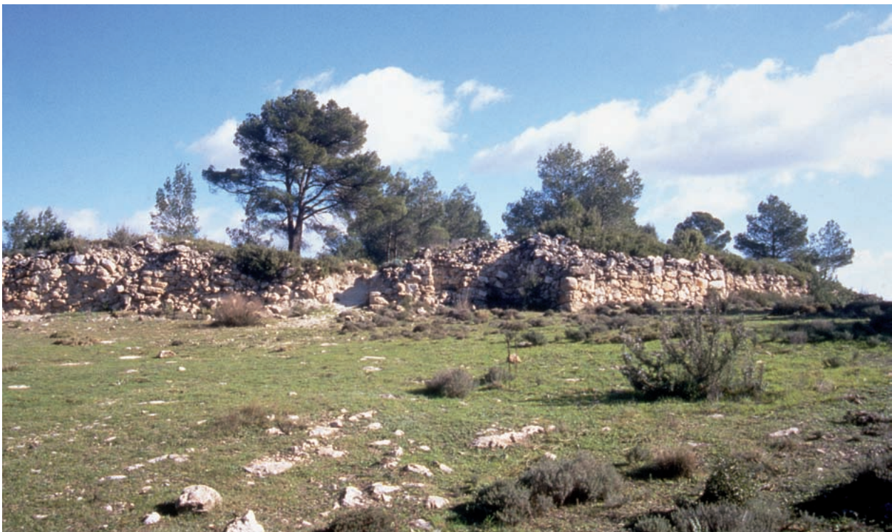
4. Torre y lienzo oeste de la muralla antes de la intervención de 1995.
