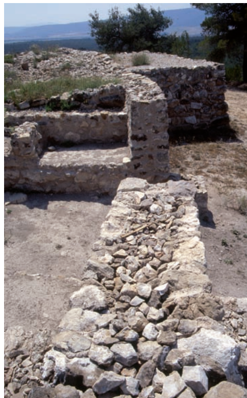
18. Coronamiento y acabado de la Puerta Oeste con relleno de piedra y grava (1998).
