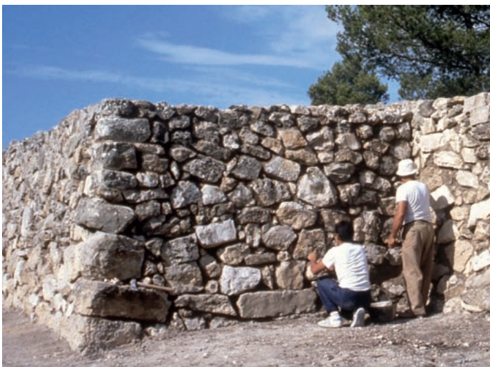
19. Operarios rejuntando el aparejo de la Torre II (1998).
