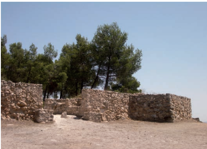
16. A. Frente oeste de la muralla y torre II restauradas (1998).
