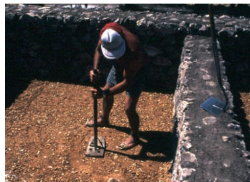
12. B. Operario apisonando la zahorra
