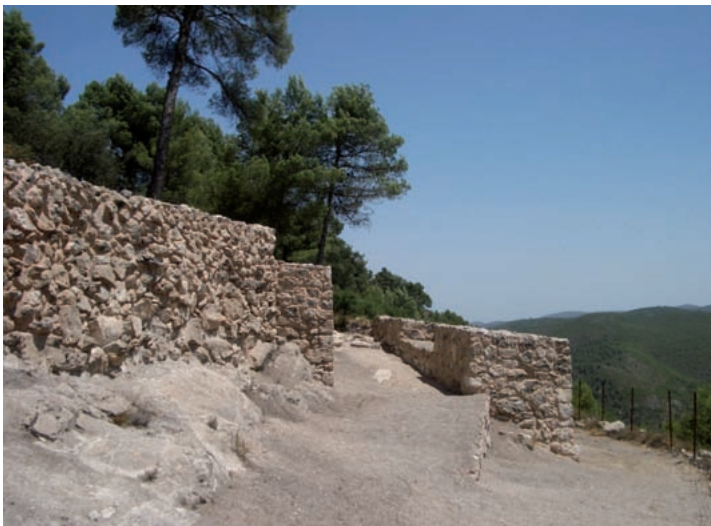
17. B. La Puerta Sur, desde el exterior, una vez consolidada (2005).
