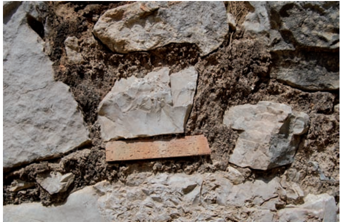
7. Señalización de ladrillo empleada en la muralla y las puertas para diferenciar el recocado de mampostería del original.
