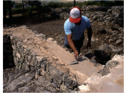
11. B. Capa de cemento, cal y arena, previa a la última hilada.
