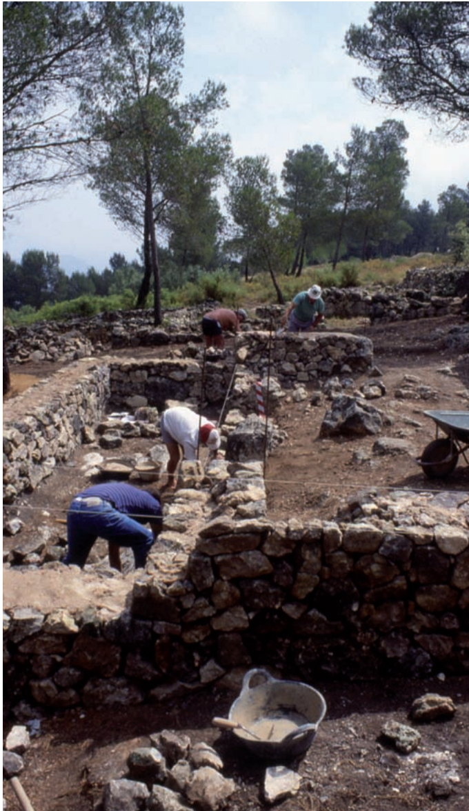
11. A. Operarios recreciendo los muros del Conjunto 2.
