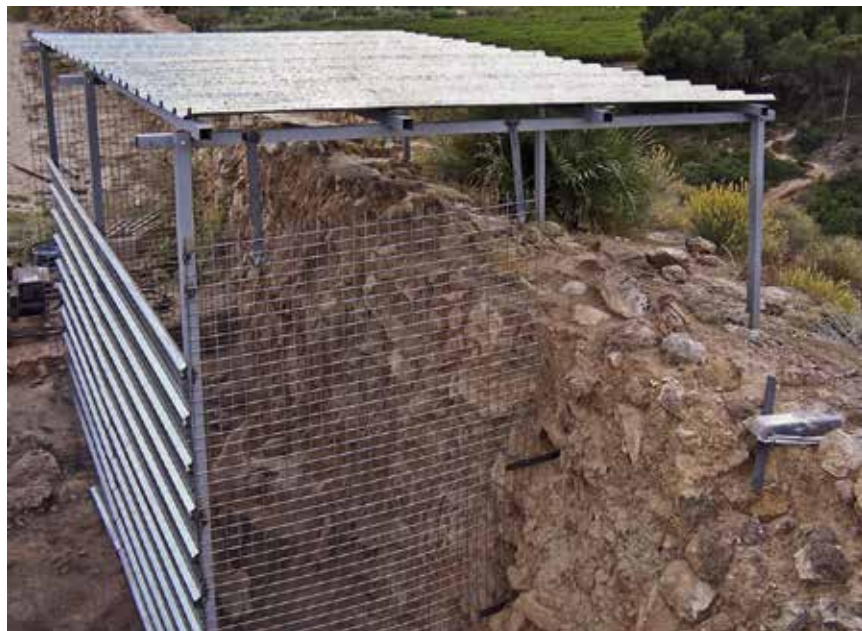
Fig. 4. Cubierta horizontal para la protección de las estructuras, con cerramientos verticales contra posibles actos vandálicos.
